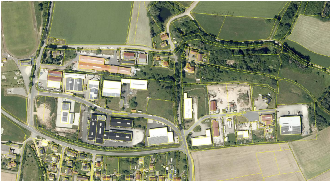
Luftbild o. M. Gewerbegebiet Fallmeisterei © Luftbild Bay. Vermessungsverwaltung 2023
